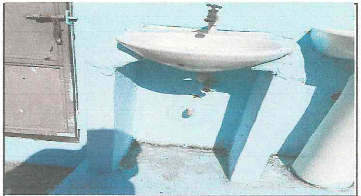
Foto 10: Pintura en muros exteriores e interiores
