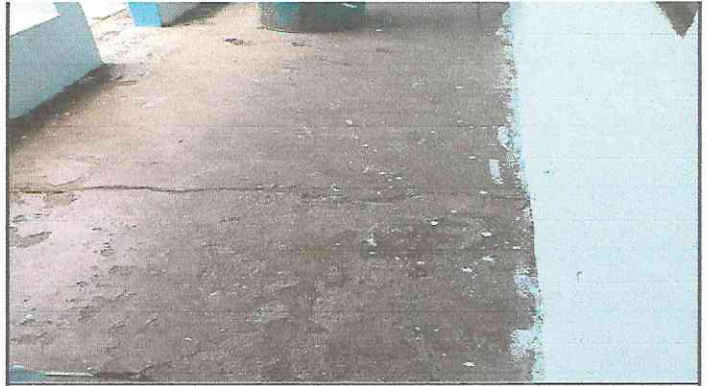
Foto 8: Reparación de piso de torta de concreto
