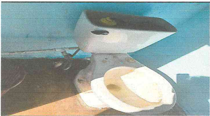
Foto 9: Sustitución de piso cerámico
